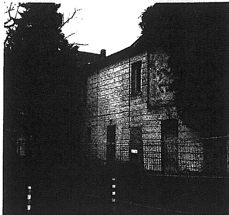
Zwischen Hauptstraße und Festhalle gammelte seit Jahrzehnten das Kutscherhaus vor sich hin. Nun haben die Sanierungsarbeiten begonnen. Foto: Siemes
